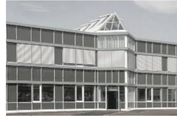
Yapı İnovasyon Merkezi, Erlangen
